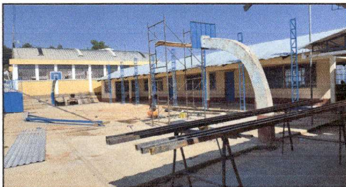
Foto 3: Area donde se está realizando la instalación de estructura y reparación de techo
