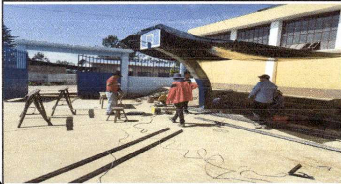
Foto 1: Area donde se está realizando la instalación de estructura y reparación de techo
