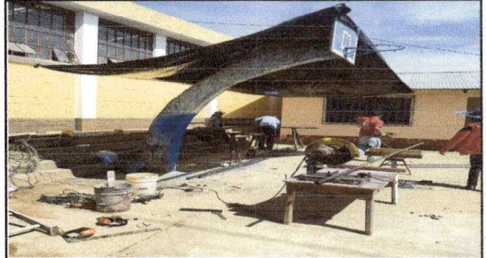
Foto 2: Area donde se está realizando la instalación de estructura y reparación de techo
