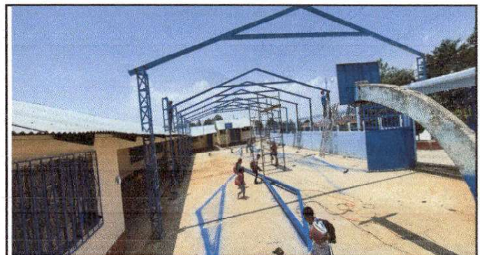
Foto 4: Area donde se está realizando la instalación de estructura y reparación de techo
