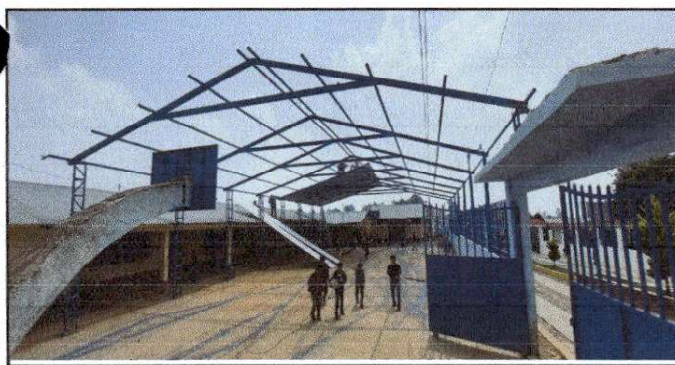
Foto 5: Area donde se está realizando la instalación de estructura y reparación de techo
