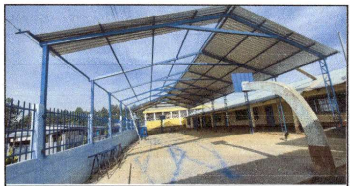
Foto 6: Area donde se está realizando la instalación de estructura y reparación de techo
